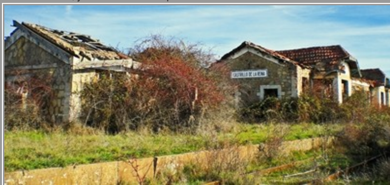
Aspecto actual de la Estación del Santander-Mediterráneo en el término municipal de Castrillo de la Reina
